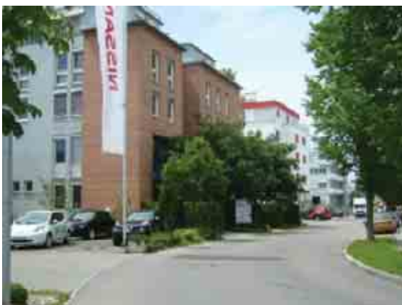
Foto 9: Mehrgeschossige Gebäude (Rudolf-Diesel-Straße)
