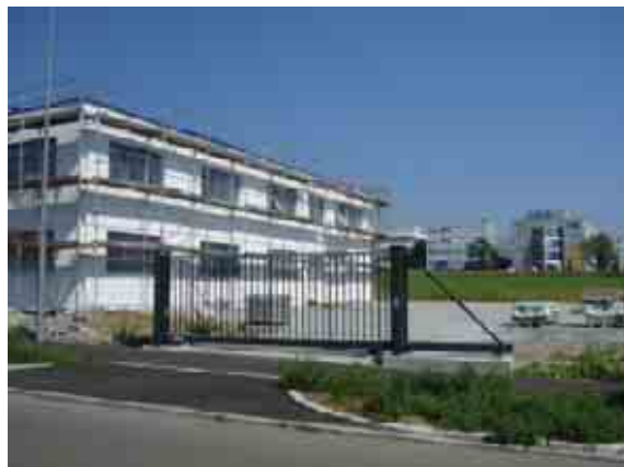
Foto 30: Gewerbebetrieb im Bau
